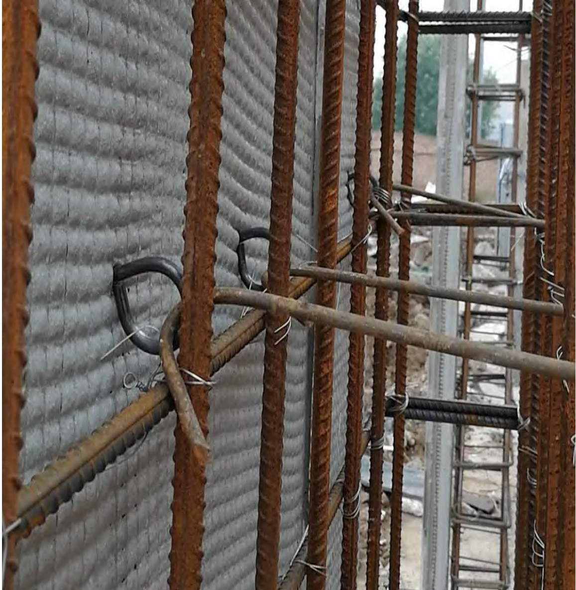
图3 PFC板预埋件与墙体钢筋通连接
